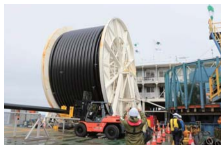
海洋深層水取水管増設工事の様子。安心・安全な水産物の供給と、水産業以外の多方面での利活用が進むことを期待します。
