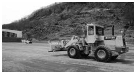
重機による整備
