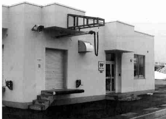
深層水 給水施設
