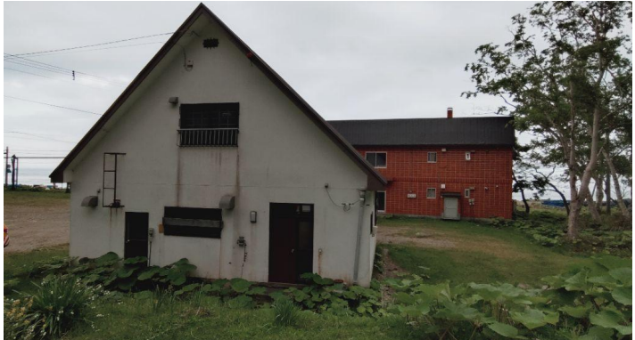
※土砂災害警戒区域（急傾斜地）に指定されています。
