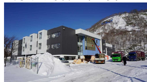
校舎全景(入口側)
